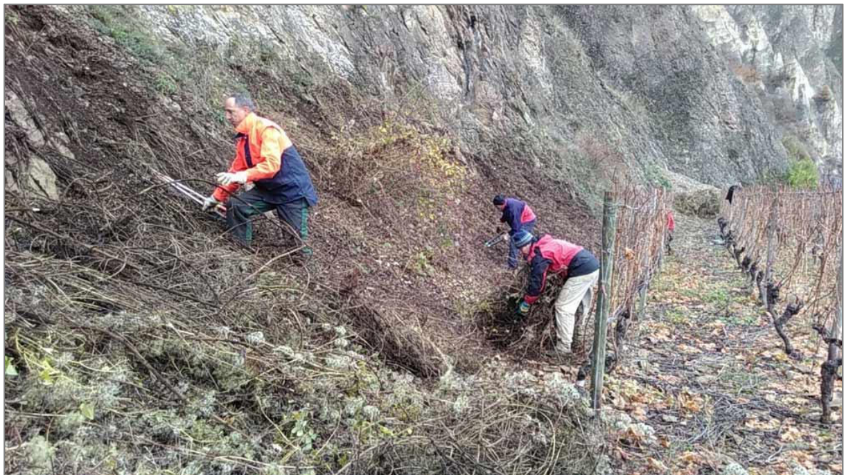
Arbeiten am Hangfuß / Weinbergsterrassen
